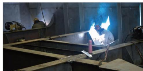
图 1 工人在狭小的船舱格子间作业
