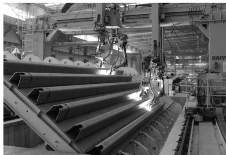
(a) U肋单元机器人焊接系统
