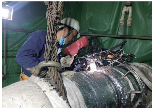
图1 丰城电厂三期现场窄间隙自动焊
